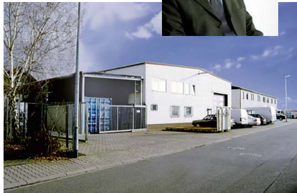
Firmengelände der Herborn GmbH in Ginsheim-Gustavsburg
